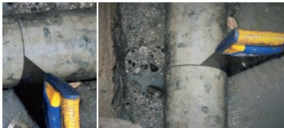
Figura 6 - Taglio di una tubazione mediante seghetto manuale (Inail Dit).
