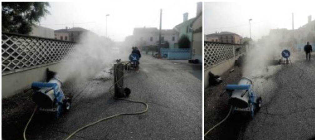
Figura 5 - Cannone nebulizzatore nell'area d'intervento.
