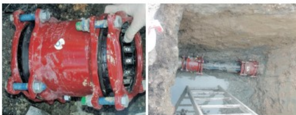
Figura 10 - Particolare del giunto di collegamento (sinistra); tratto di tubazione nuova in sostituzione di quella ammalorata (destra).
